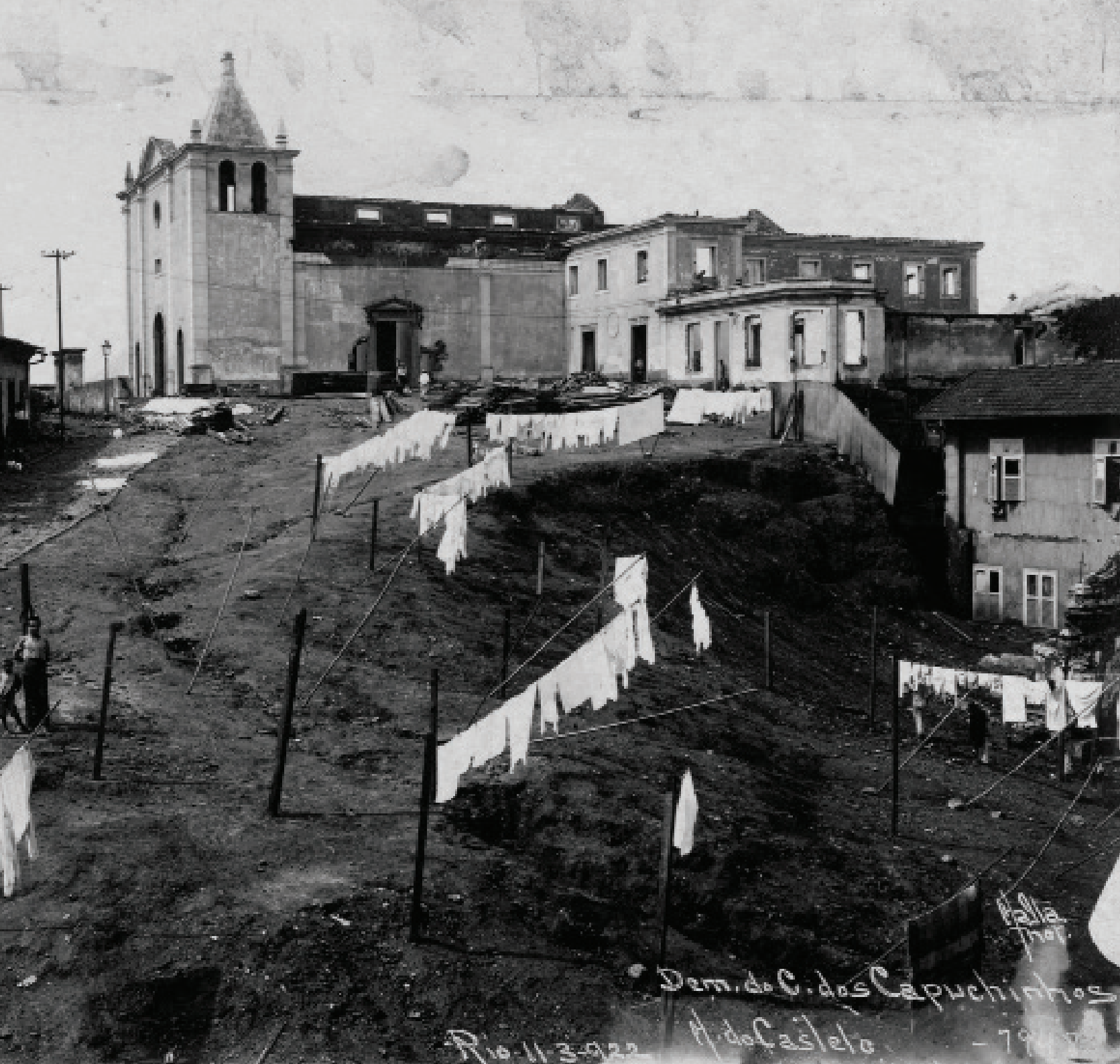
Demolição do Convento dos Capuchinhos, no Morro do Castelo Acervo da Fundação Biblioteca Nacional
